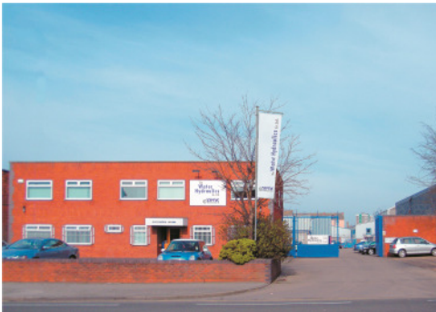
Fertigung in Hull, England
